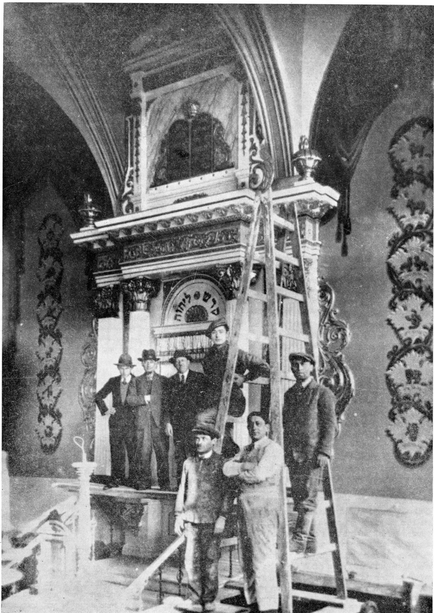
Rénovation de la synagogue en 1934
