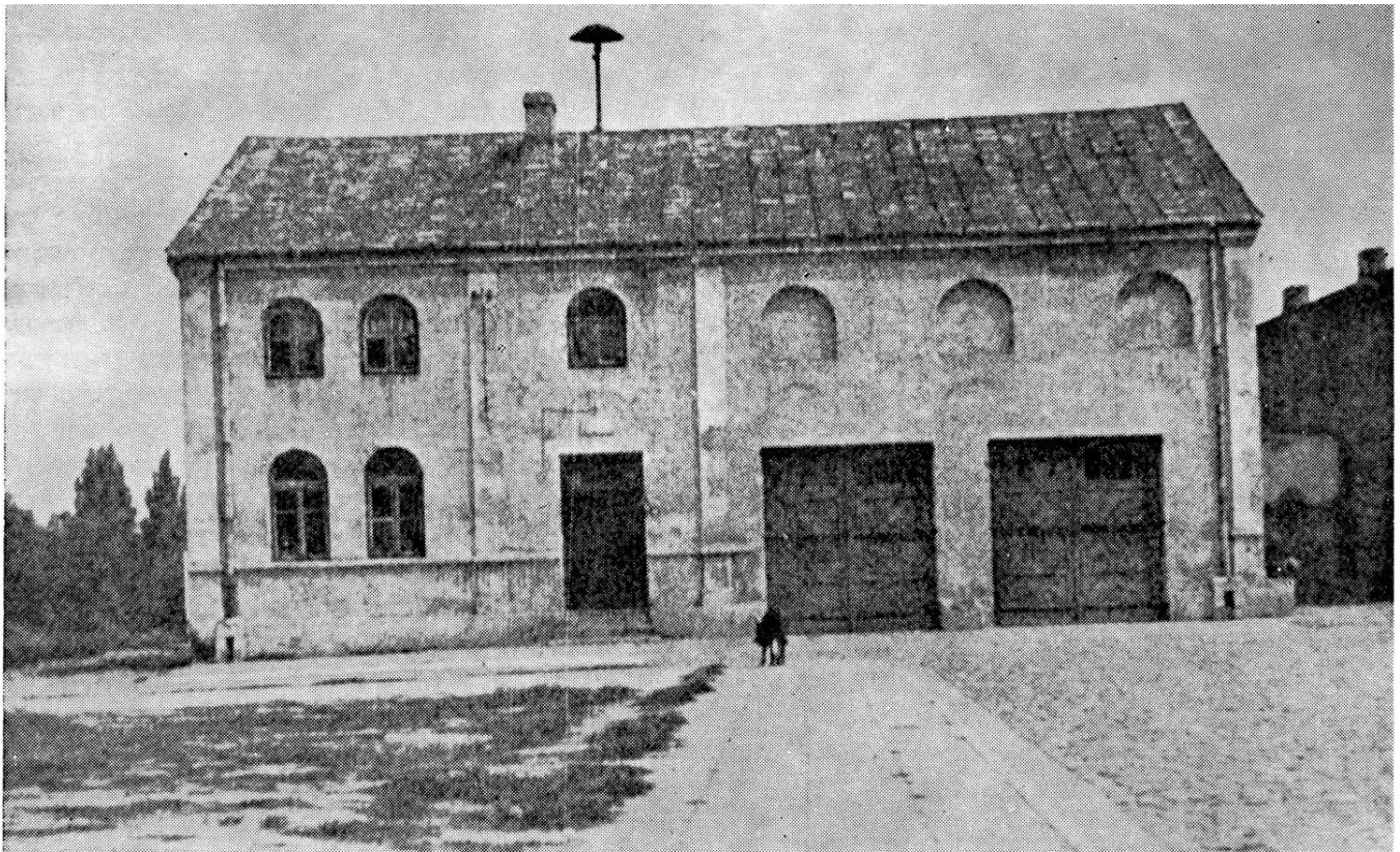
Beit HaMidrash en Kutno se transformó en... una estación de bomberos
